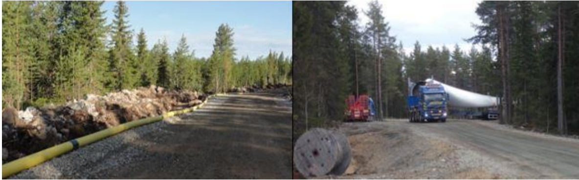
Kuva 24. Vasemmalla esimerkki tuulivoimapuiston rakennus- ja huoltotiestä. Oikealla tuulivoimalan osia kuljetetaan erikoiskuljetuksina (FCG).
