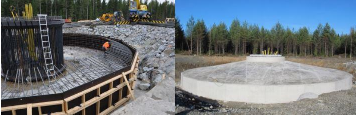
Kuva 26. Tuulivoimalan perustusten rakentamista (FCG).
