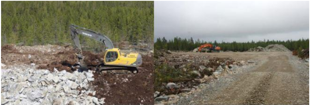
Kuva 25. Tuulivoimapuiston rakentaminen alkaa huoltoteiden ja pystytysalueiden rakentamisella (FCG).
